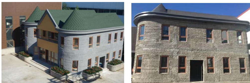
Figura 36 - Edifício impresso pela HuaShang Tengda. Fonte: BUREM (2016)
