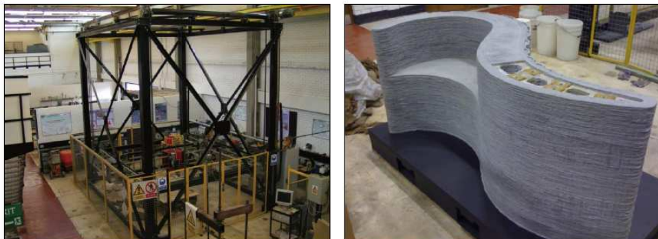
Figura 18 - Concrete Printing. Fonte: LIM et al. (2012)
