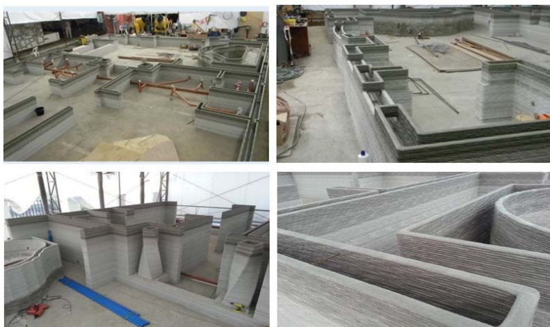
Figura 37 - Detalhes da impressão da casa de festas. Fonte: BUREM (2016)
