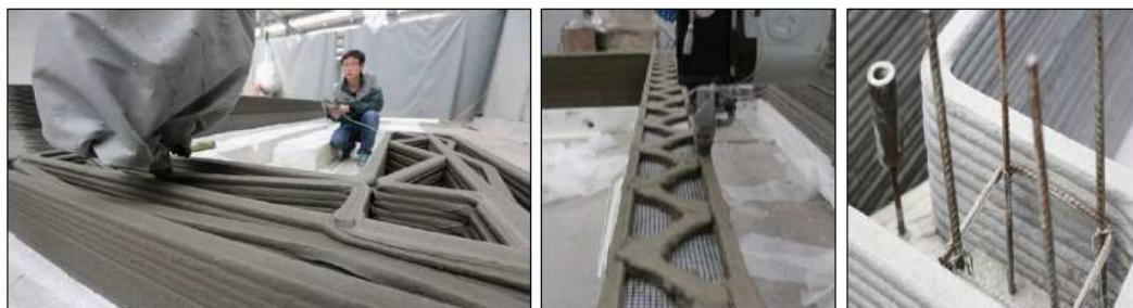
Figura 31 - Paredes impressas pela Yingchuang e reforço estrutural. Fonte: CHARRON (2015)
