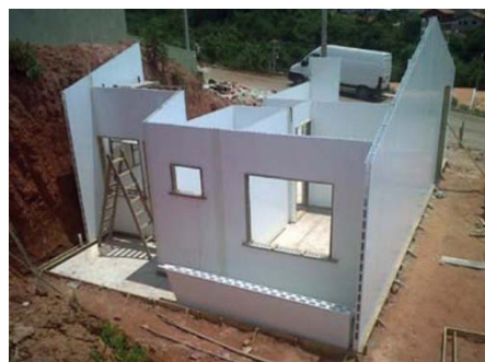
Figura 13 - Casa em Concreto PVC. Fonte: GLOBAL HOUSING (2013)
