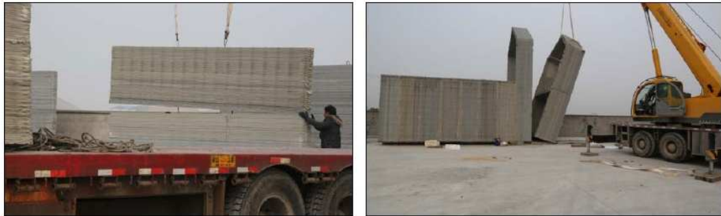
Figura 32 - Içamento das partes impressas. Fonte: CHARRON (2015)
