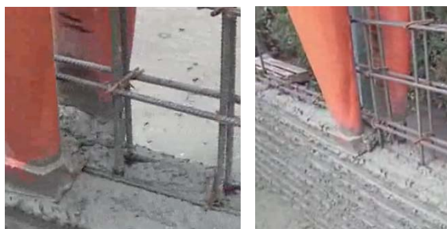
Figura 37 - Impressão das camadas no sistema da HuaShang Tengda. Fonte: BUREM (2016)
