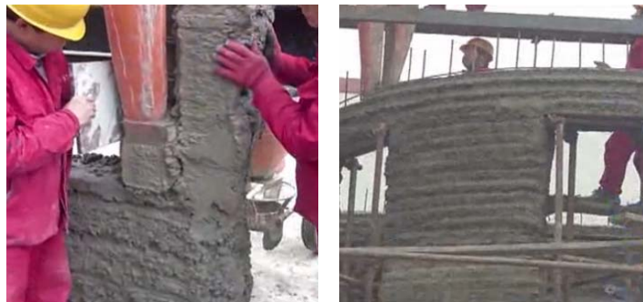
Figura 38 - Suporte e escora nas aberturas das janelas. Fonte: BUREM (2016)
