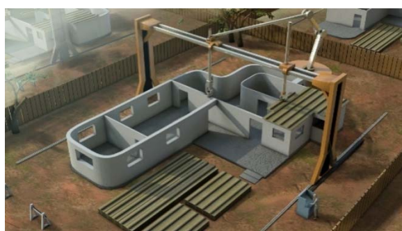
Figura 16 - Esquema de construção com Contour Crafting. Fonte: CONTOUR CRAFTING (2016)
