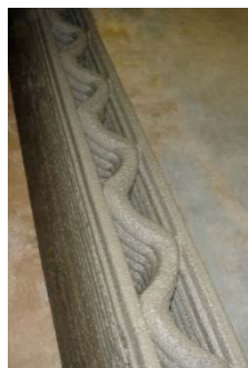
Figura 15 - Parede impressa. Fonte: CONTOUR CRAFTING (2016)
